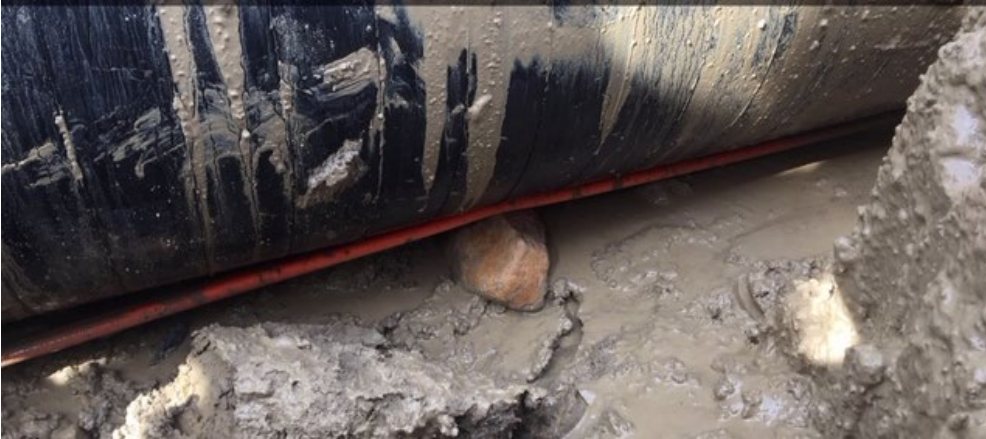
Conduit crushing
